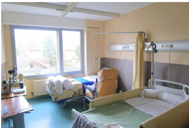
UNE CHAMBRE RÉNOVÉE DU PAVILLON FRANÇON. ON APERÇOIT LES RAILS LÈVE-MALADES AU PLAFOND.
