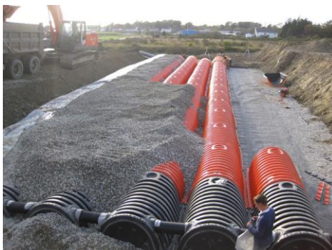
Exemple de bassin de rétention enterré à structure alvéolaire
